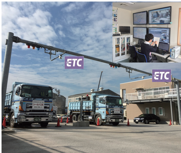
写真1 ETCアンテナと運搬管理状況
