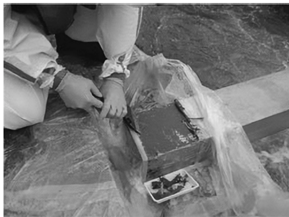
剥離剤を用いた湿式剥離工法
