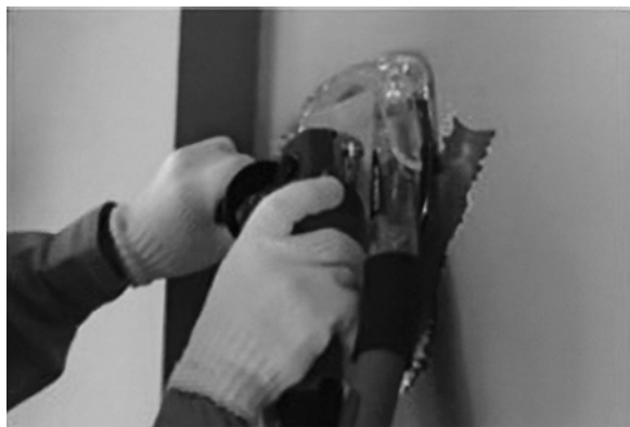
サンダー及び吸引装置を用いた乾式剥離工法
